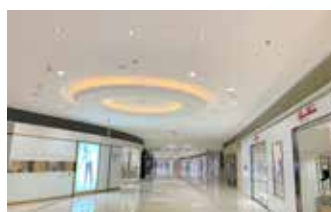
石膏板天花吊頂
