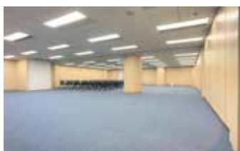
礦棉板天花吊頂
